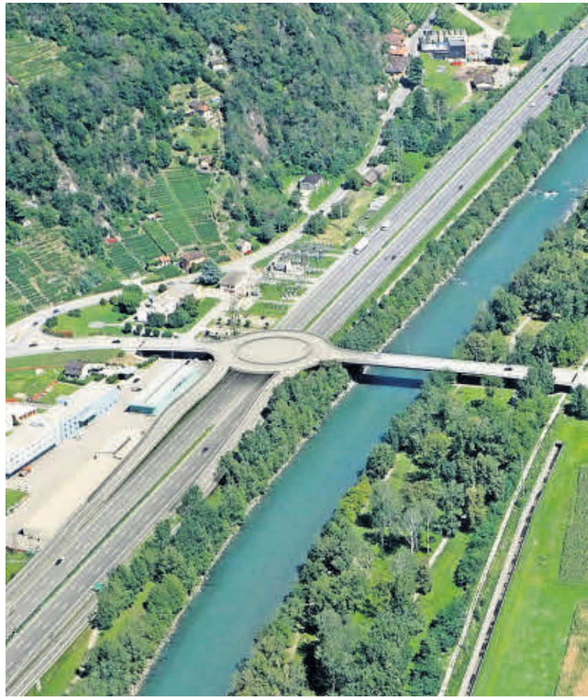
SOPRAELEVATA La turborotonda del semisvincolo sarà costruita sopra l'A2 e avrà un diametro di 60 metri. (Foto Ustra)
