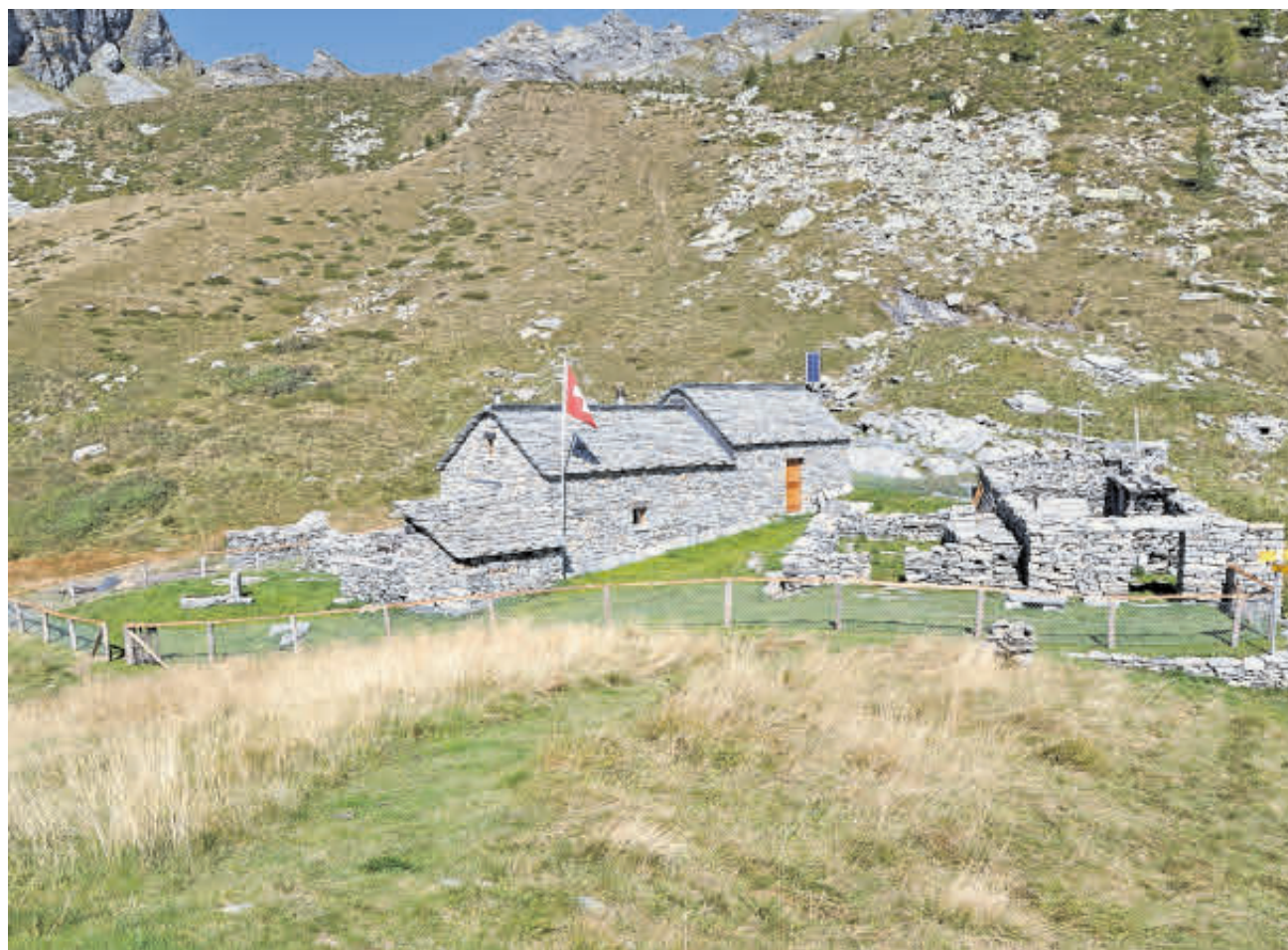
UN PARADISO Gli edifici (già risanati e da risanare) dell'Alpe Canaa, a 1.843 metri di quota. (Foto Patriziato Lodano)
