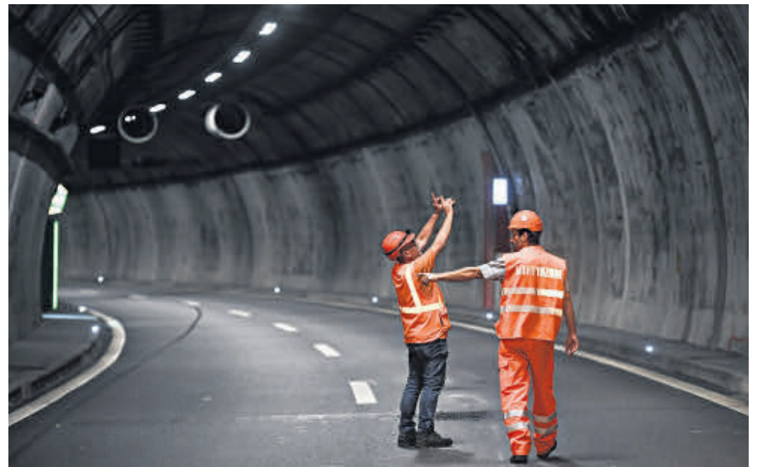
Addetti alla manutenzione controllano la galleria del San Salvatore.
